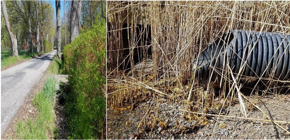
Figur 38: Till vänster visas vägdike inom ARO3. Till höger visas utlopp för ARO3 efter Fagerdalavägen.
