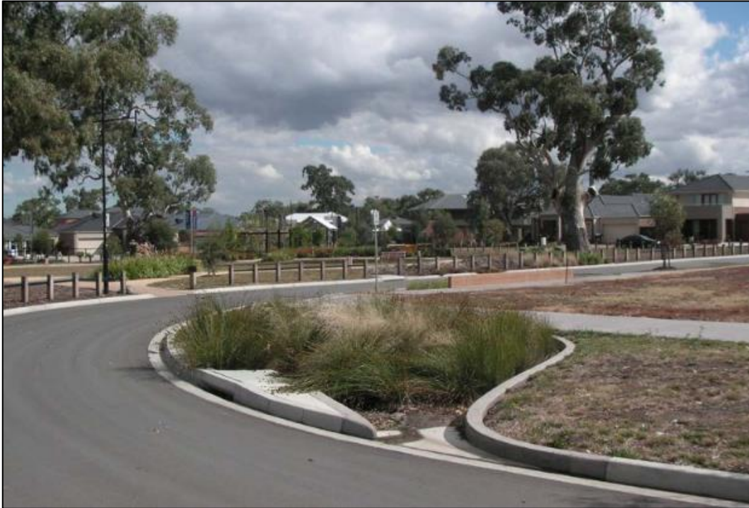
Figur 6-4. Öppning i kantsten, inlopp växtbäddar (Waterbydesign, 2014).
