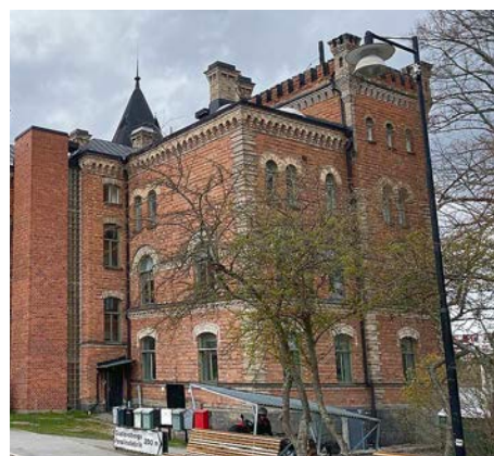
Fasad av tegel ned till mark och glasblock. Fönster med murverksbalk
