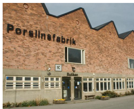
Fasad av tegel med markerad betongsockel
