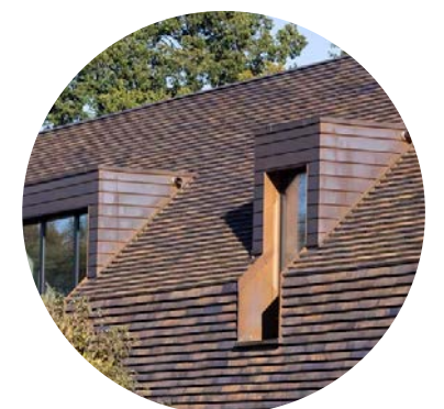
Pedersen Cover Enhetligt uttryck som binder ihop tak och fasad
