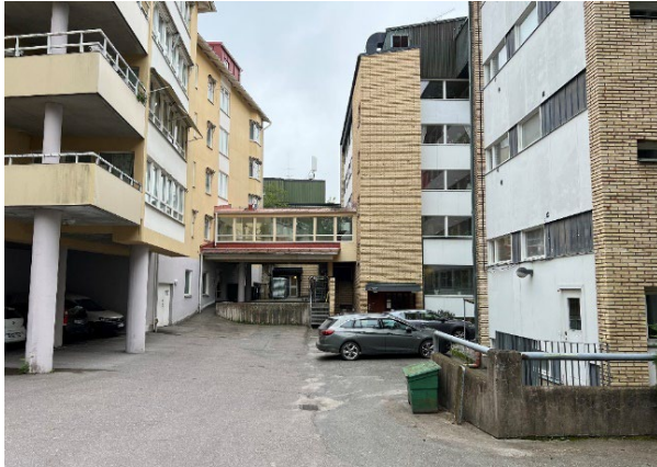
Figur 33 Innergård på befintliga Serviceboendet är hårdgjord för fåtalet parkeringar och leveranser till storkök och vårdverksamhet.
