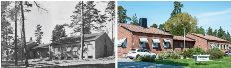
Figur 25. Förlossningshemmet på 1950-talet respektive idag. Den omgivande tallskogen har idag ersatts med en parkering och en gräsplan. (WSP)
