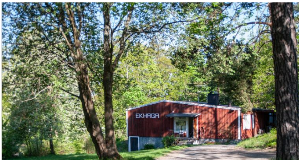
Figur 22. Ekhaga används för kommunal verksamhet och ligger i lövskogspartiet mot Skärgårdsvägen. (WSP)
