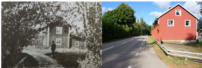
Foto till vänster från 1902 och foto till höger visar samma byggnad idag.
