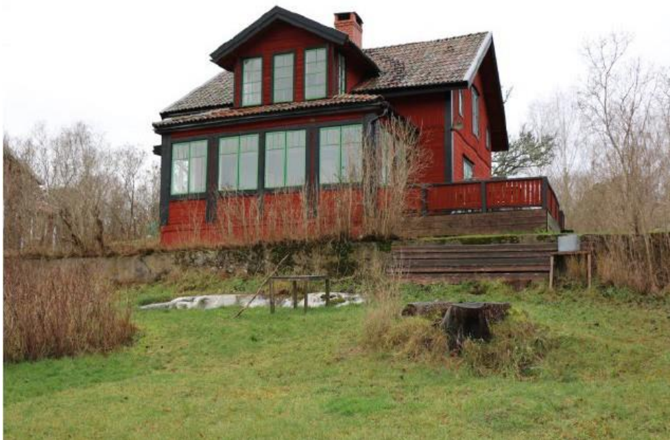
Figur 17. Foto på villabyggnad i jugendstil på fastigheten Björkvik 1:148 (2). Fotot är taget ur kulturmiljöutredningen (Tengbom, 2019).
