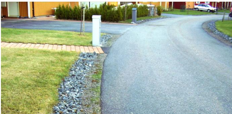
Figur 4 Makadamdiken kan användas för att avleda och fördröja dagvatten från vägar, gator och parkeringsytor. De kan kombineras med andra dagvattensystem.
