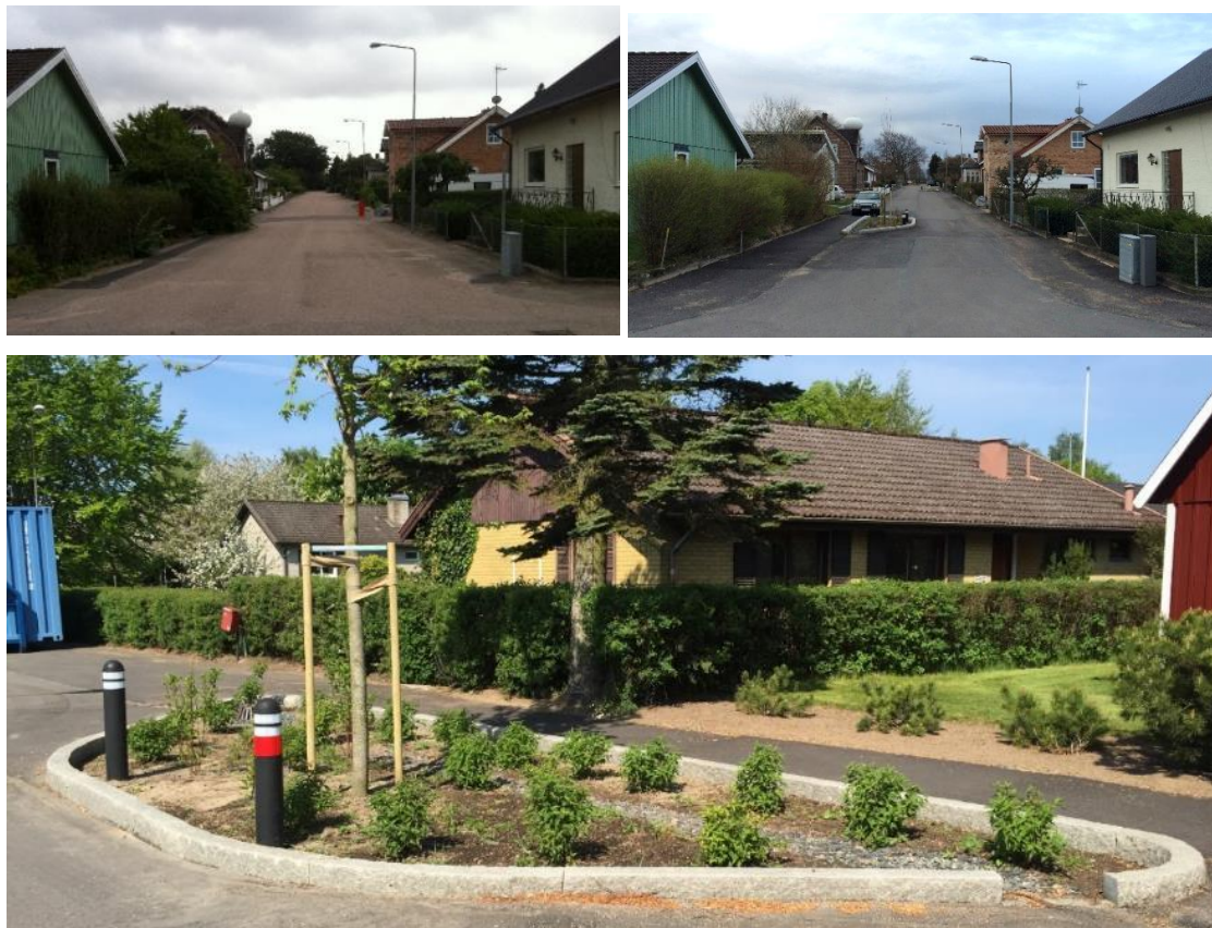
Bild 4 Parkgatan i Ängelholm. Ovan till vänster innan anläggande, till höger efter anläggande och nedan närbild på en regnplantering.
