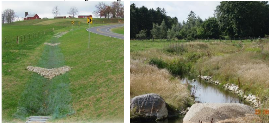
Bild 3 T.V. Ett sektionerat svackdike. T.V. Ett restaurerat krondike i anslutning till jordbruksmark, Skåne.
