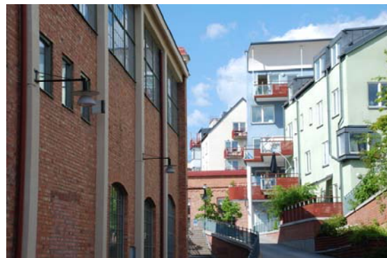
Renoverade industribyggnader som samverkar med ny bebyggelse, foto AIX
