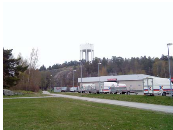
Vattentornet på höjden bakom bensinstationen, foto Structor
