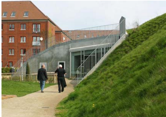
Idrottshall som är väl integrerad med intilliggande park genom grön överbyggnad, foto Värmdö kommun
