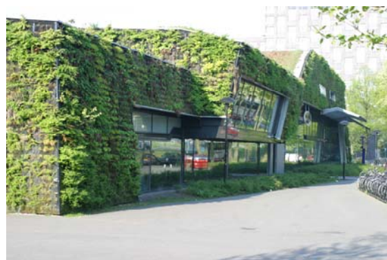
Byggnad som är väl integrerad med intilliggande park, även förebild för t ex idrottsanläggning, foto Värmdö kommun
