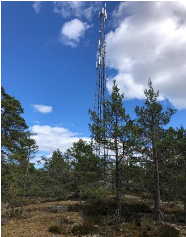
Figur 8. Foto på vy mot öst. Befintlig telemast (Foto: Värmdö kommun, 2022).
