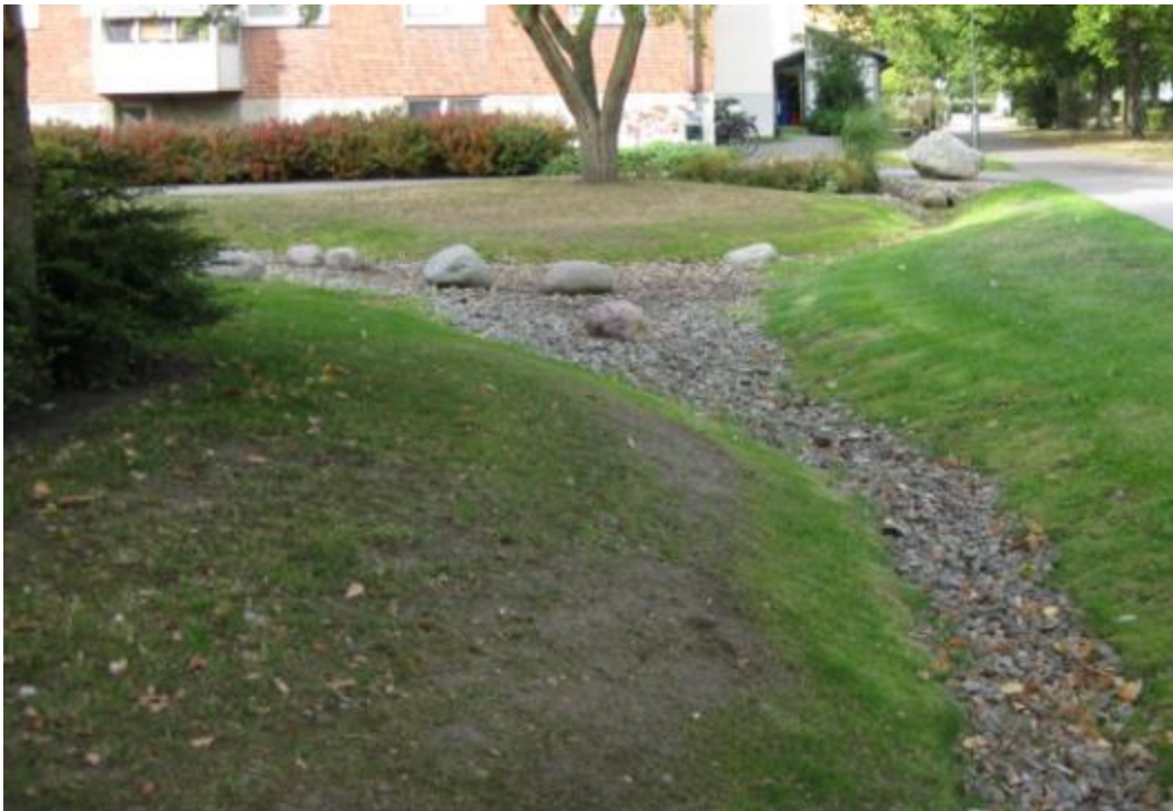
Figur 8 Illustrationsbild av gräsbeklätt svackdike med sektionering
