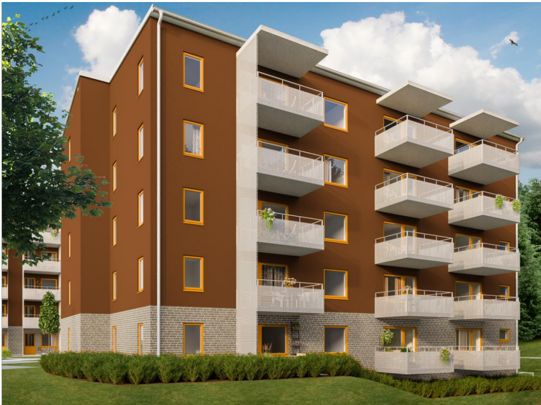
Figur 1 Omhändertagande av slänt sker genom att fasaden möter upp de lägre marknivåerna i norr.
