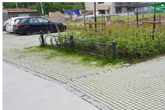
Figur 12. Exempel på genomsläpplig beläggning som alternativ till helt hårdgjord yta vilka minskar avrinningen.
