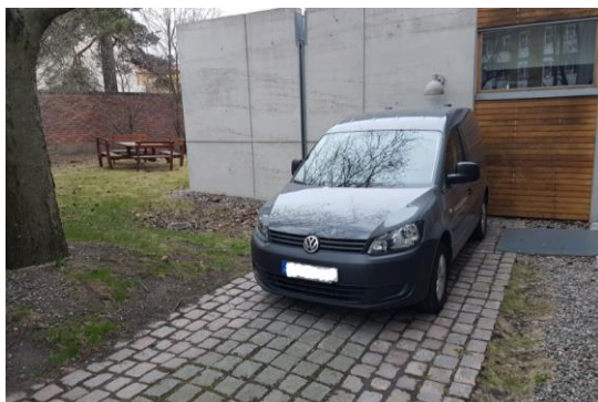
Figur 12. Exempel på genomsläpplig beläggning som alternativ till helt hårdgjord yta vilka minskar avrinningen.
