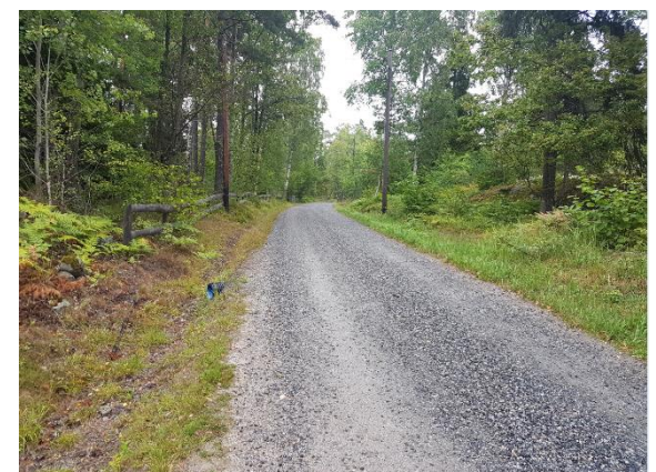
Figur 14 Dike längs med väg.
