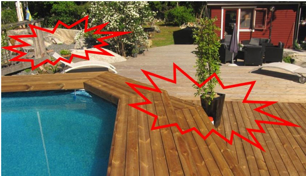
Figur 24 Exempel på hur det inte ska se ut. Stor träaltan minskar möjligheten för infiltration, krukväxter behöver bevattnas och berget är rensat på jordlager vilket ökar avrinningen.
