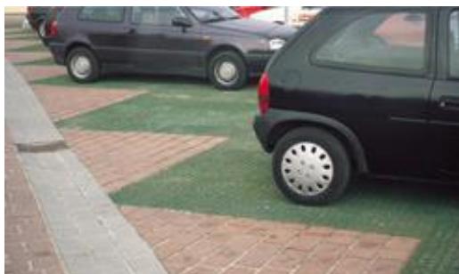
Figur 22 Parkering med gräsarmering.
