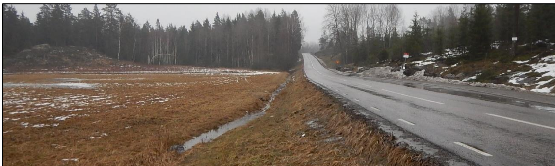
Figur 6. Bild från Saltarövägen (riktning österut).
