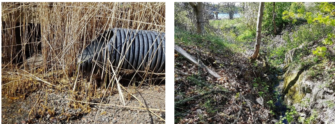
Figur 7. Till vänster visas utlopp för ARO3, efter Fagerdalavägen. Till höger visas dike som leder till utlopp för ARO1 via vilket större delen av planområdet avvattnas.
