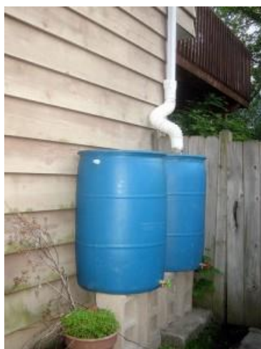
Figur 13. Till vänster visas regntunnor för uppsamling av takvatten och till höger stuprörsutkastare med rännal och erosionsskydd avleder takvattnet ut till grönyta.
