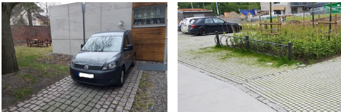
Figur 12. Exempel på genomsläpplig beläggning som alternativ till helt hårdgjord yta vilka minskar avrinningen.
