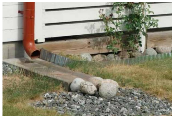
Figur 13. Till vänster visas regntunnor för uppsamling av takvatten och till höger stuprörsutkastare med rännal och erosionsskydd avleder takvattnet ut till grönyta.
