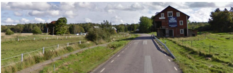
Figur 2-6 Fagerdalavägen vi stall Tuna. Parallellt med vägen löper en ridväg. Räcke på vägens södra sida. Bildkälla: Google Maps
