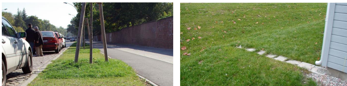
Figur 19. Till vänster, en vanlig gräsmatta eller annan naturmark kan användas för att fördröja och rena dagvatten. Till höger, takvatten kan ledas via stuprör till gröna ytor för infiltration.
