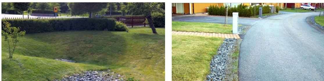
Figur 18. Till vänster, anläggningar i mark samlar upp och fördröjer dagvatten i markytan. Rening uppstår när vattnet infiltrerar vidare i naturliga eller uppbyggda jordlager. Till höger, Makadamdiken kan användas för att avleda och fördröja dagvatten från vägar, gator och parkeringsytor. De kan kombineras med andra dagvattensystem.
