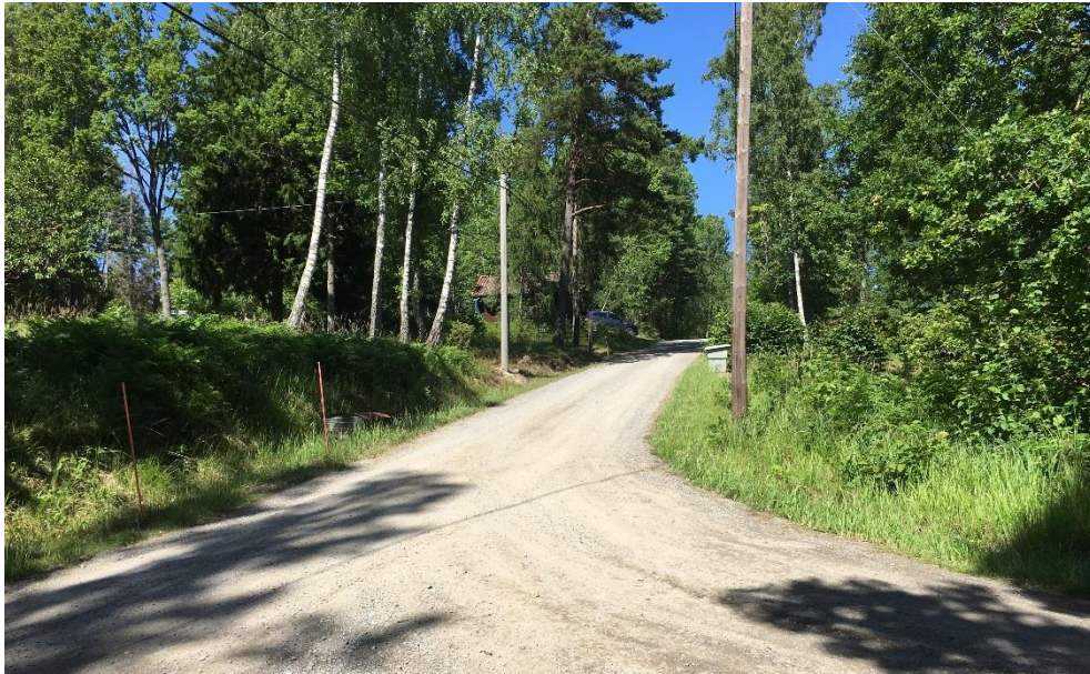
Figur 2-8 Ryttingevägen, vars centrala del fungerar som en uppsamlingsgata, har begränsad bredd och brant lutning ned mot vattnet i söder.
