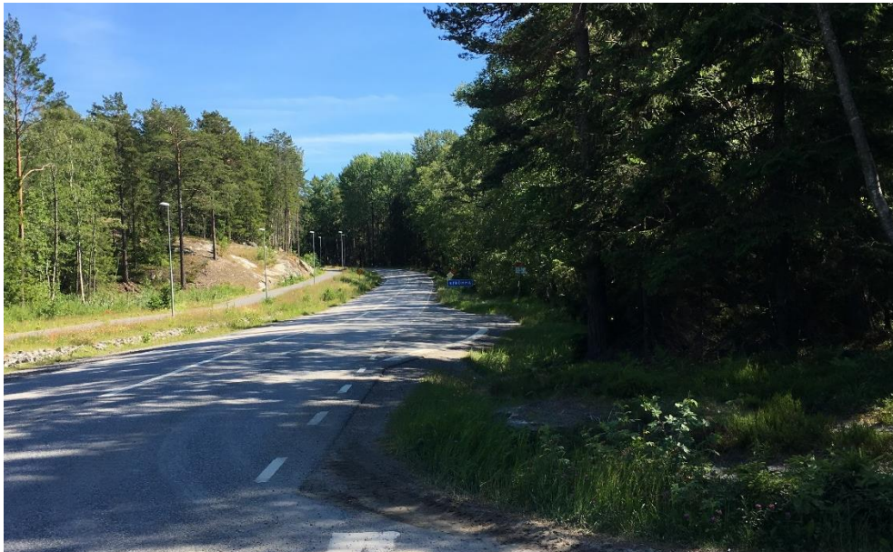
Figur 2-4 Hållplats Ryttingevägen i riktning mot Strömmadal saknar separerad väntyta för resenärer och anslutande gångväg.
